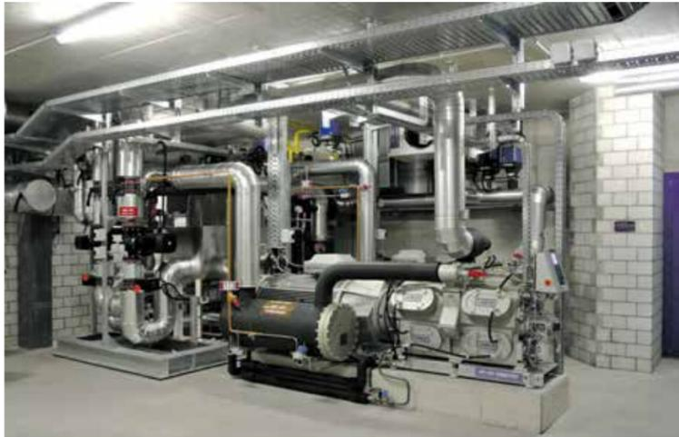
Die Ammoniak-Wärme-Pumpe entzieht dem Abwasser die Wärme.
