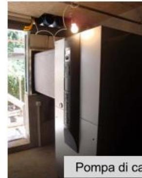
Pompa di calore aria-acqua
